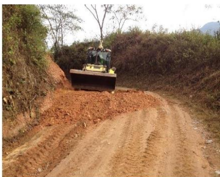
Fotografía 33. Ensanchamiento de la vía
