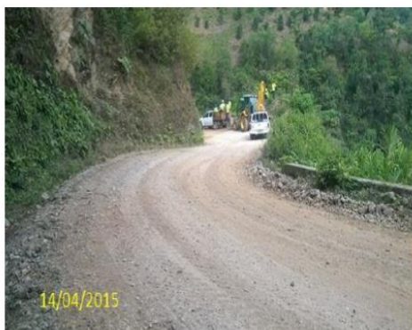
Fotografía 37. Tramo antes de estabilizar
