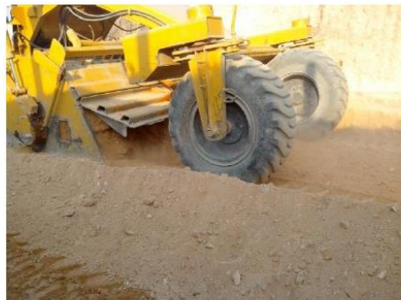
Fotografía 8. Disgregación del material con recicladora
