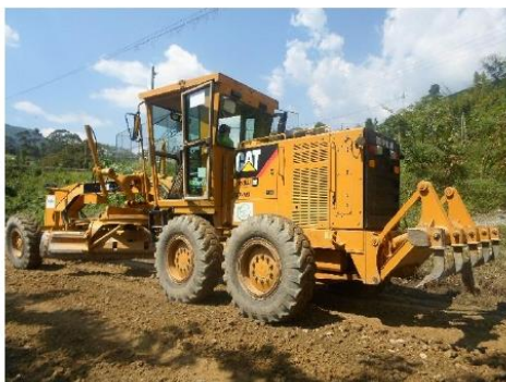
Fotografía 21. Conformación de la vía
