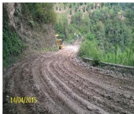
Fotografía 38. Tramo escarificado
