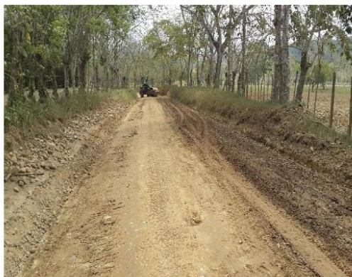
Fotografía 17. Compactación de la vía
