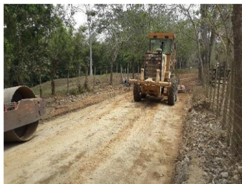
Fotografía 16. Conformación de la vía
