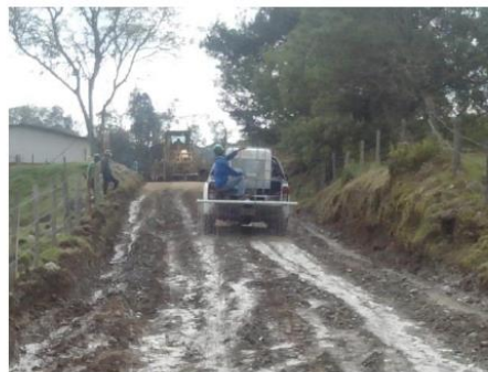
Fotografía 26. Aplicación de producto
