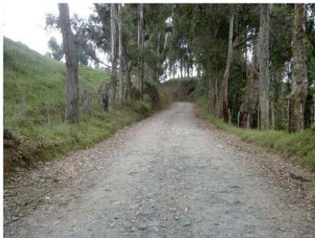
Fotografía 31. Tramo antes de estabilizar
