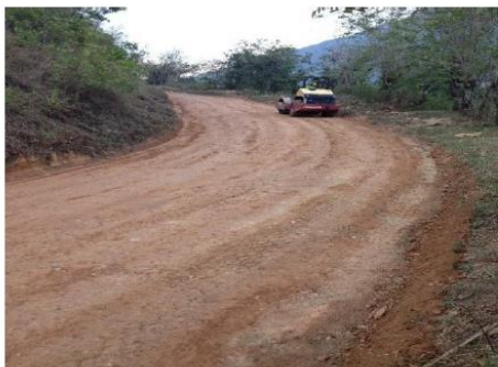
Fotografía 35. Compactación de la vía
