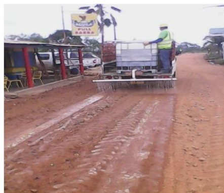
Fotografía 12. Aplicación de producto
