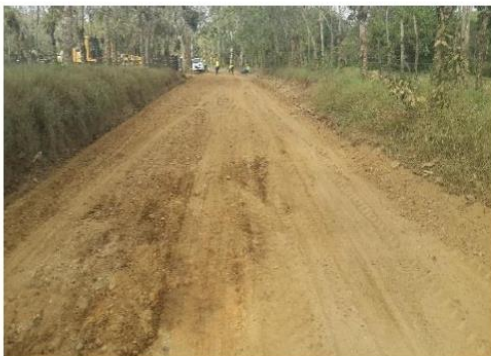
Fotografía 15. Vía conformada
