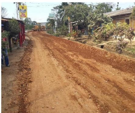
Fotografía 11. Escarificación de la vía
