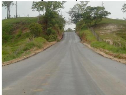
Fotografía 6. Tramo terminado con protección superficial
