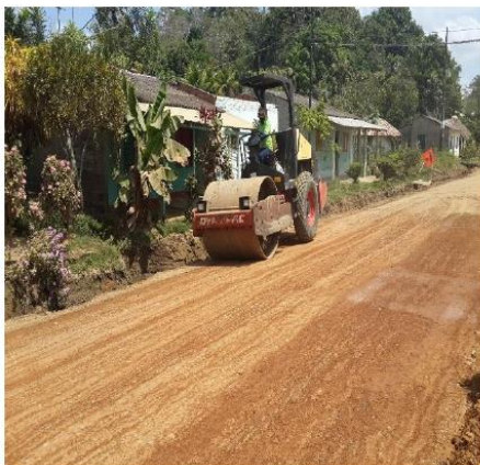
Fotografía 13. Compactación de la vía
