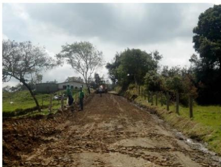
Fotografía 27. Conformación de la vía
