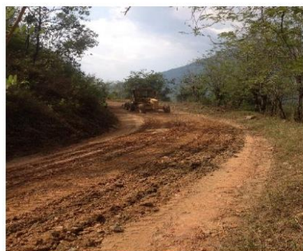
Fotografía 34. Escarificación de tramo
